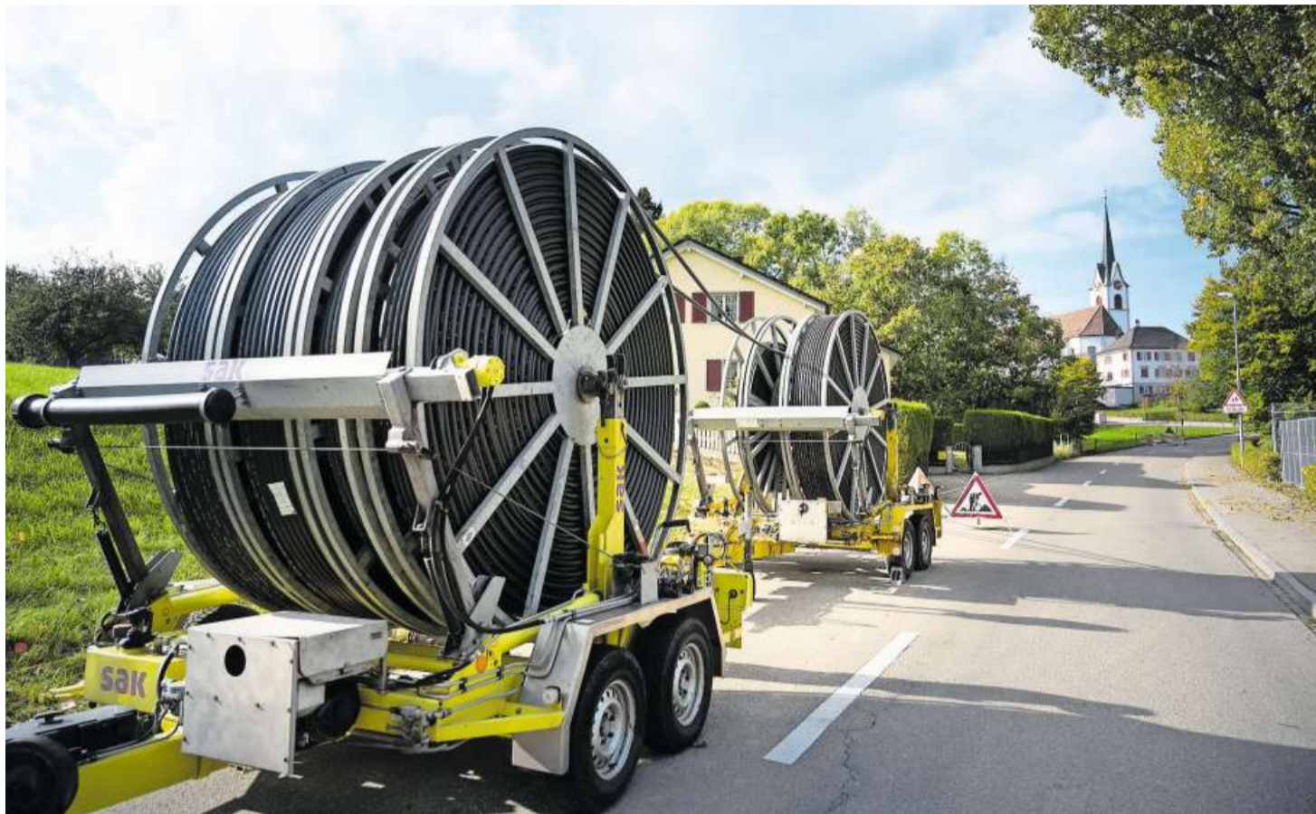
Bald sollen solche Glasfaser-Ladungen auch ins Luzerner Hinterland geliefert werden.
