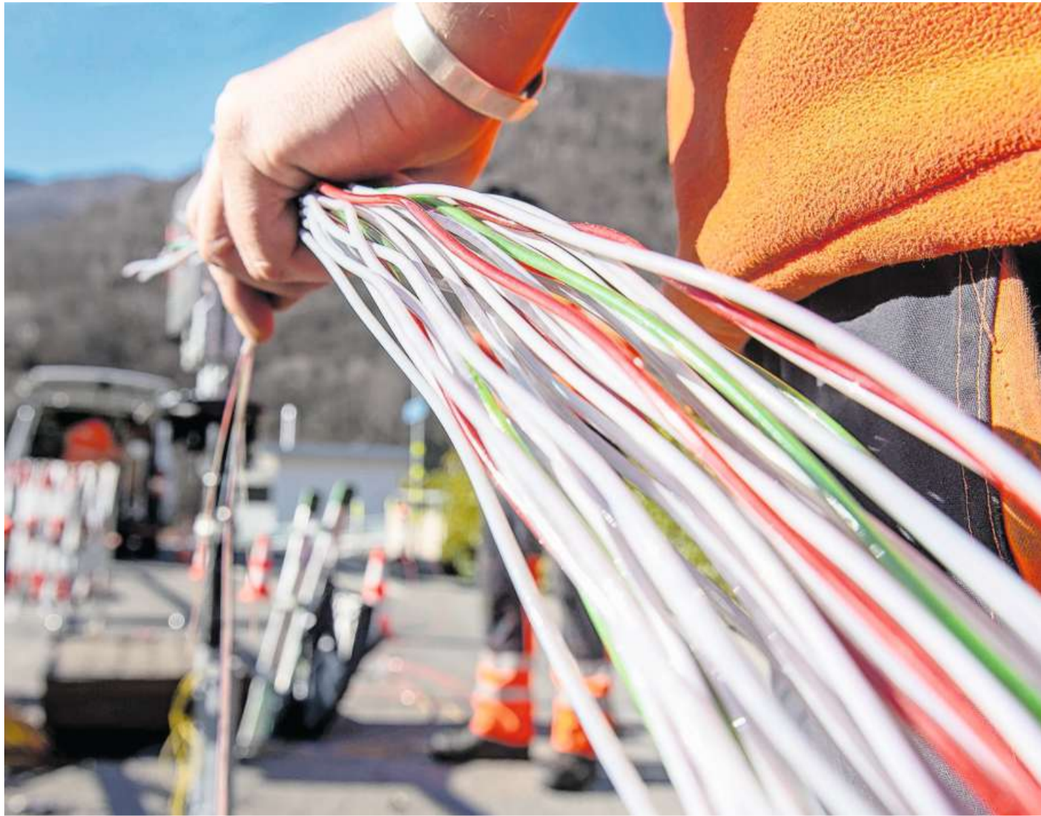
Ein Arbeiter montiert Glasfaserkabel der Swisscom für den Internetanschluss von Privathaushalten.
