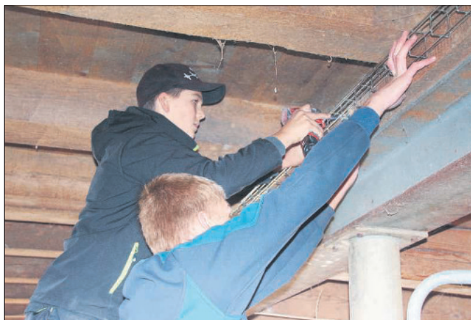
David Renggli (links) beweist viel Geschick beim Hantieren mit der Bohrmaschine.
