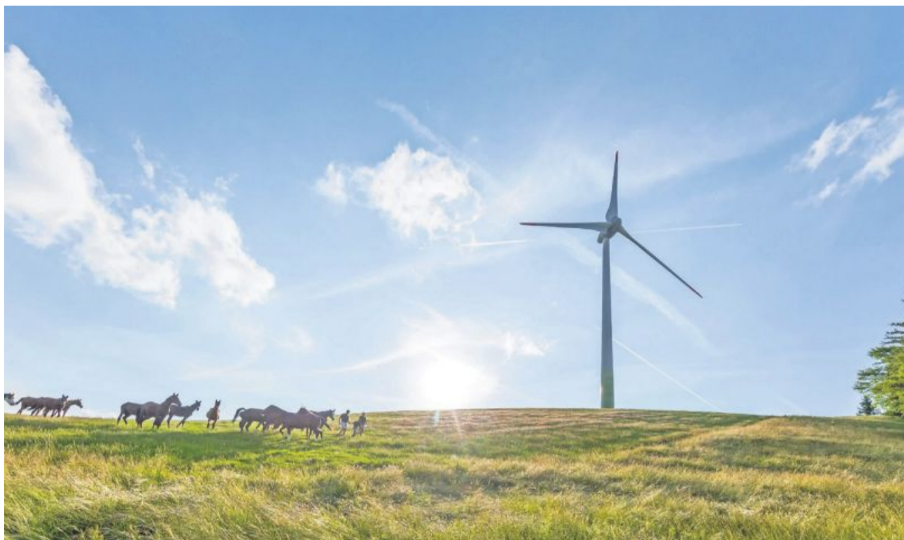
Die Rotoren des Lutersarni-Windrades in Entlebuch produzieren mehr Strom als erwartet. Foto ckw
