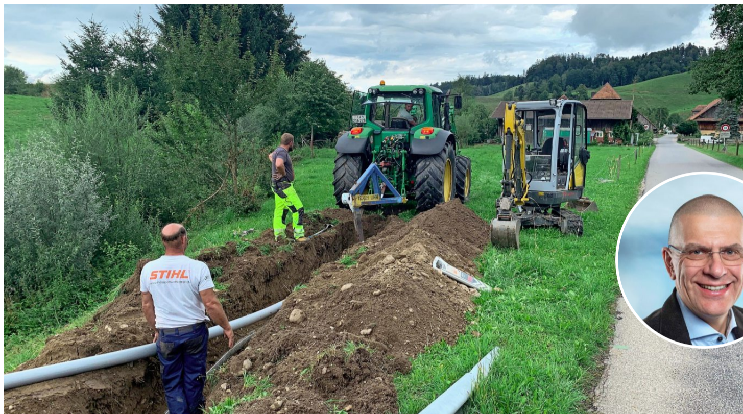
In Ruswil werden bereits Leerrohre für die Glasfaserleitungen eingesetzt. Für Valentin Wepfer (kleines Bild) war der Baustart ein Befreiungsmoment.
